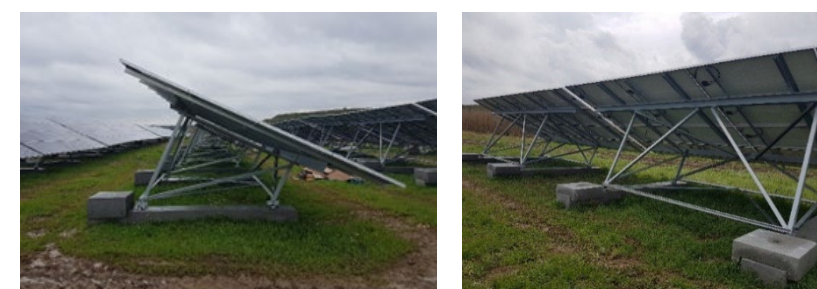
Exemple de fondations béton – Q ENERGY France
